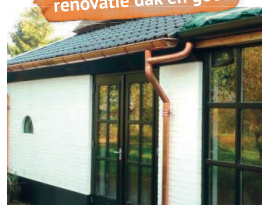
renovatie dak en goot
